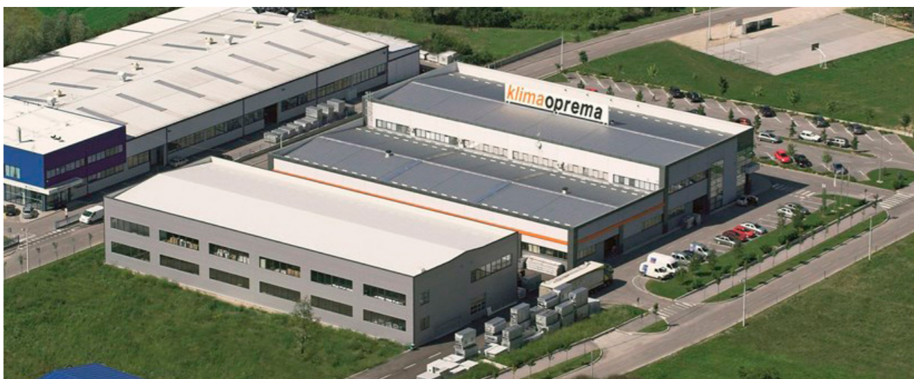
Production and office space in Gradna, Samobor from 2005 Proizvodno-uredski prostor u Gradni, Samobor iz 2005. godine
